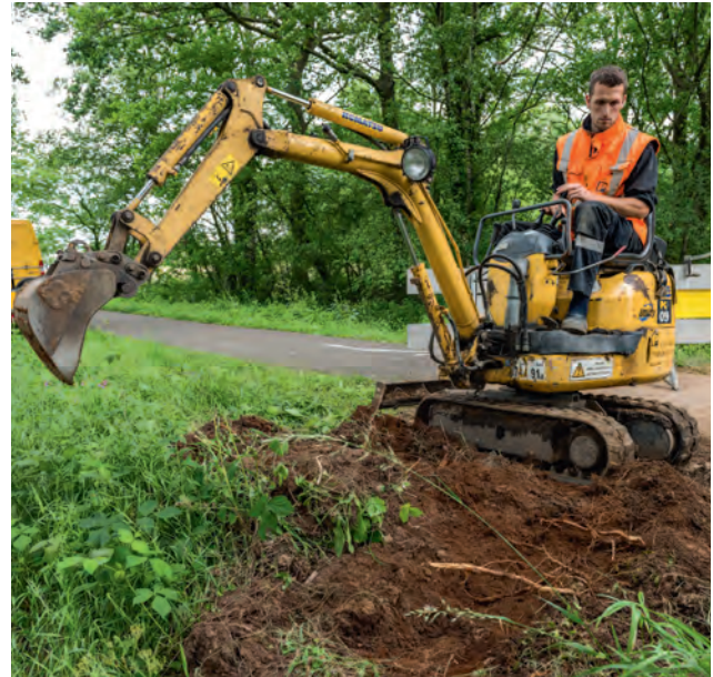
Graven van de proefsleuf
