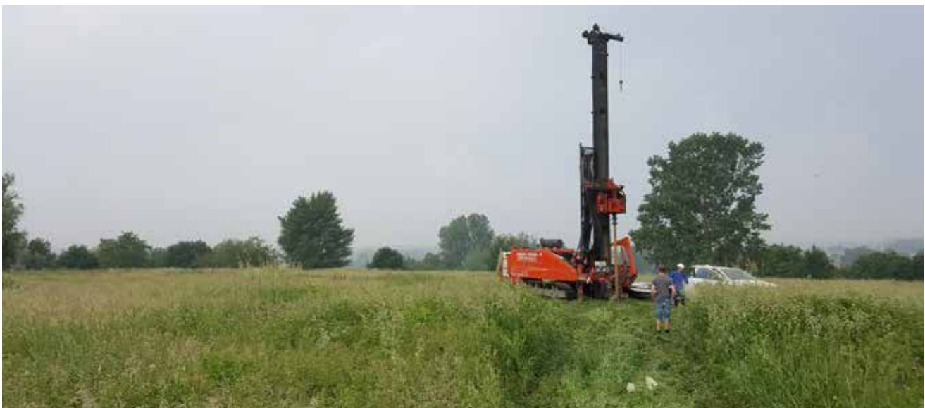
Een van de nieuwe peilbuizen zit in het centrum van de vuilstort. De plaatsing hiervan was in de wijde omtrek zichtbaar.
