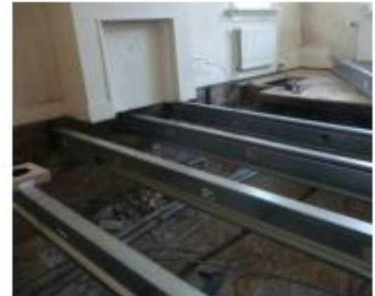
vervangen vloer door damp-dichte vloerconstructie
