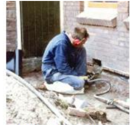
aanbrengen loodslab
