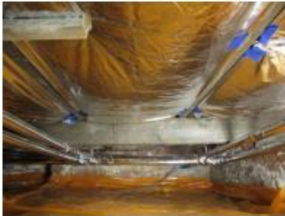
aluminium zakken onder vloer
