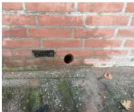
nieuwe ventilatie-opening naast bestaande
