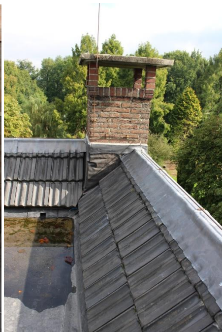
Voorbeeld van een recent dicht gelegde zakgoot bij Huis Klarenbeek. Links zijn de spanten van het dakvlak zichtbaar met daarboven een ingebrachte vloer Rechts het platte dak met rondom een opstand van het schuine dakdeel.
