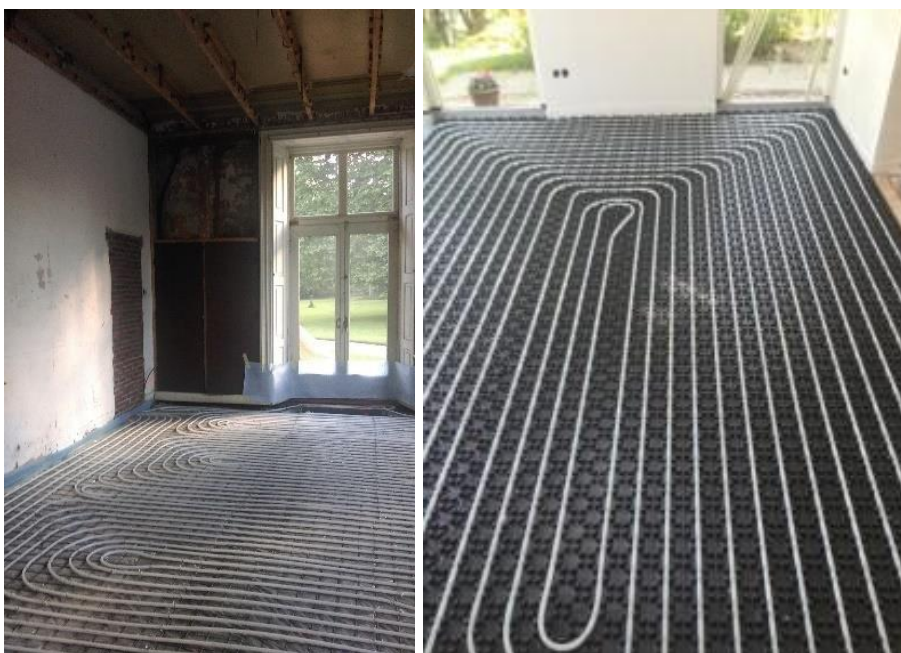
Voorbeelden van de aanleg van vloerverwarming. Links met buizen op wapeningsnet (ca. 50 mm vloerdikte); rechts met een zogenaamde noppen verdeelplaat (minimaal 60 mm vloerdikte).
